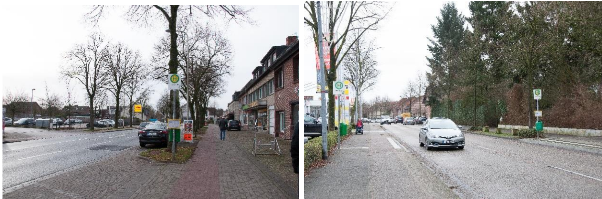
(Abb. Bushaltestelle Tönnissen Center, Bordsteinkanten abgesenkt./ Abb. Rollstuhltaugliche Straßen. (Kunz)
