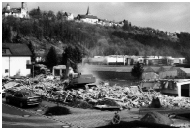
Abriss von Gebäuden des alten Eduard-Knoll-Wohnzentrums 2001
