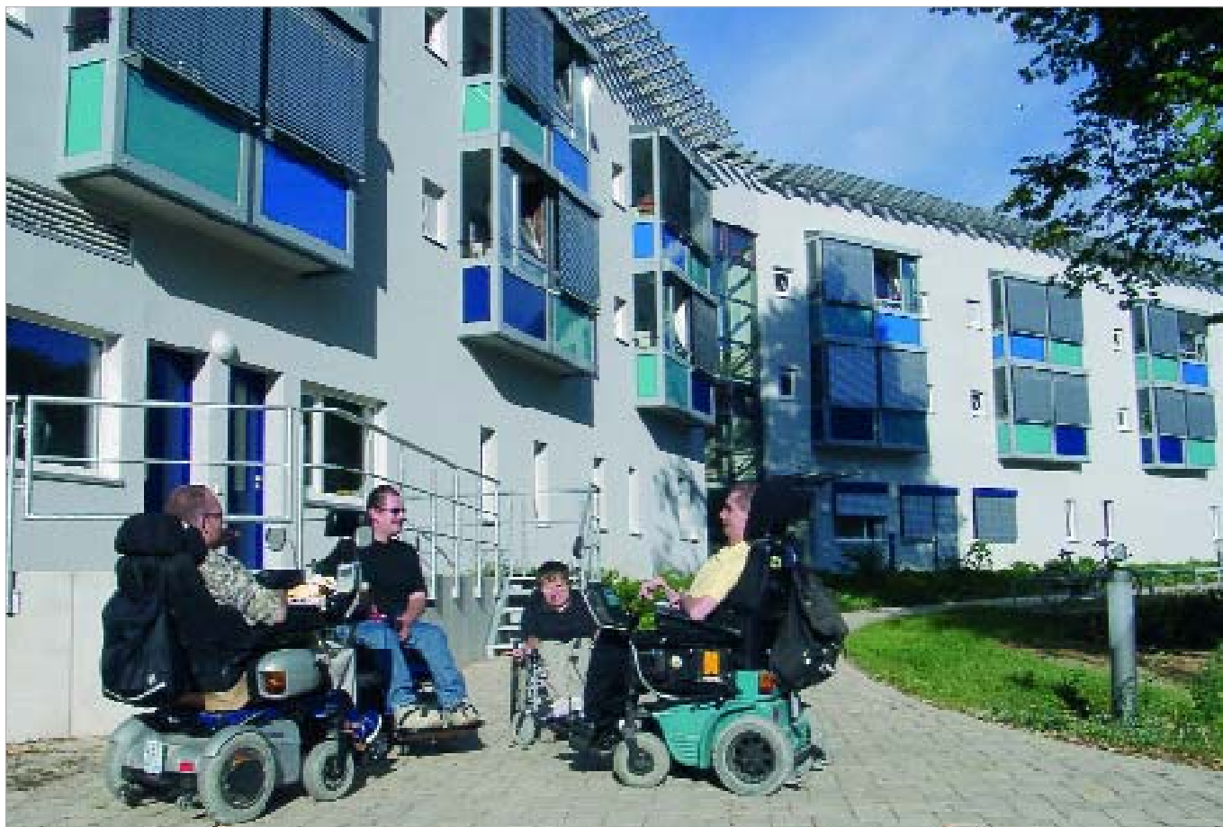
Der Neubau des Eduard-Knoll-Wohnzentrums in Krautheim
