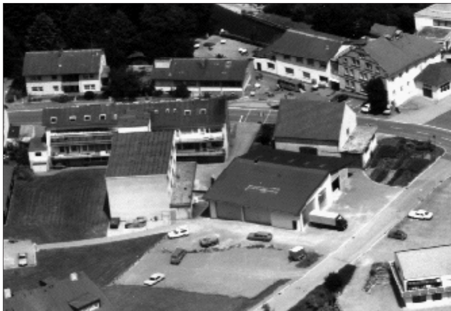
Die BSK-Gebäude in Krautheim Mitte der 80er Jahre (rechts oben die Alte Mühle, am unteren Bildrand das Areal, auf dem heute der neue WfB-Gebäudekomplex steht).
