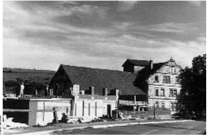
Zweiter Bauabschnitt des alten Eduard-Knoll-Wohnzentrums (ca. 1967)
