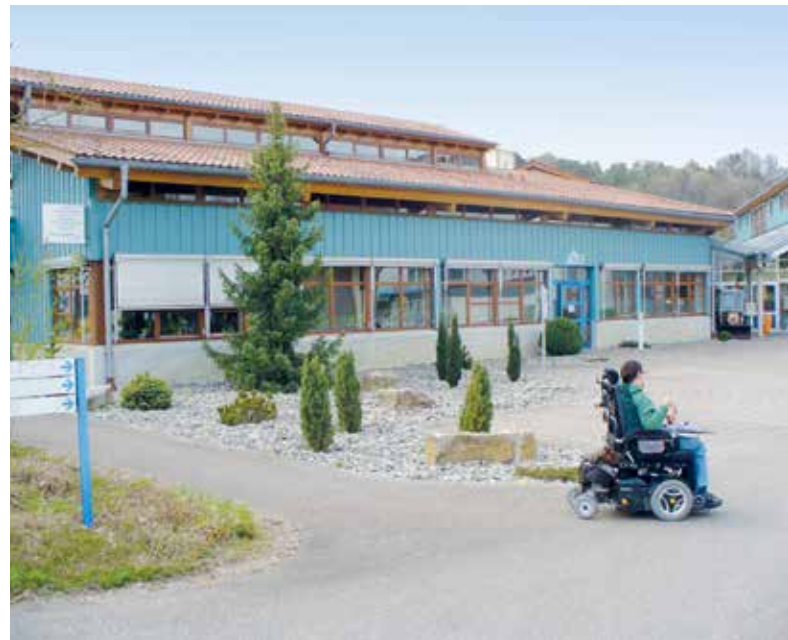
Blick auf den Gebäudekomplex der Krautheimer Werkstätten
