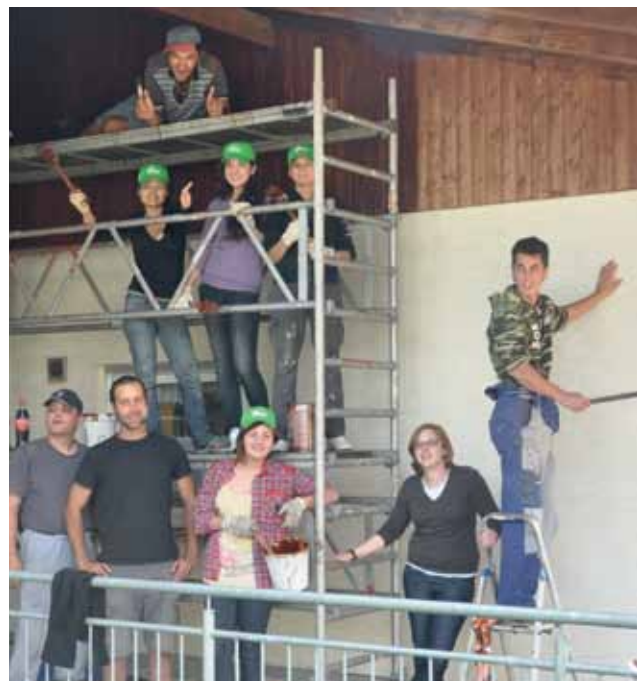
Das Team vom Internationalen Bauorden half bei Sanierungsarbeiten
