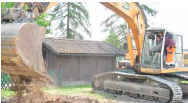
Spatenstich für Betreutes Wohnen in Krautheim: Der schwerbehinderte EKWZ-Bewohner Klaus Lehmann übernahm symbolisch den ersten Aushub mit dem Bagger
